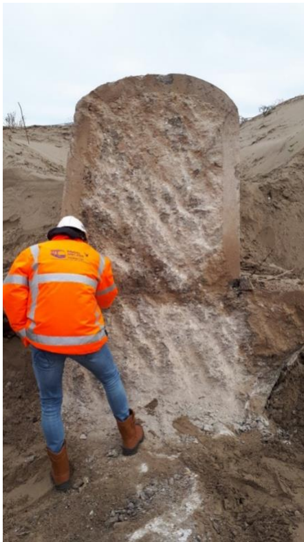
Verwijderde deel Atlantikwall
