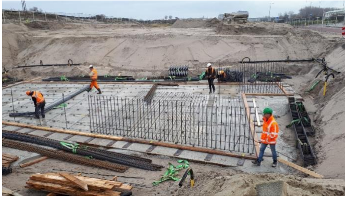
Keldervloer station Hoek van Holland Strand
