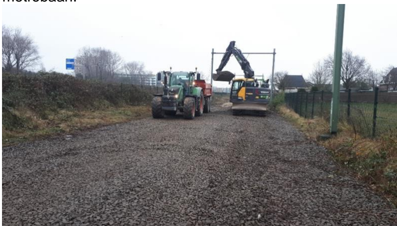
Opscheppen ballastmateriaal
