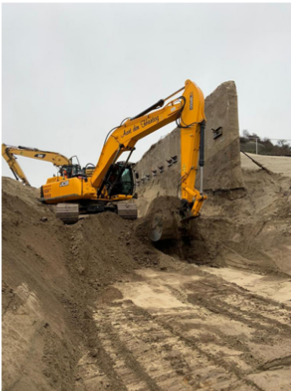
Afgraven voorbelasting naast soilmixwand
