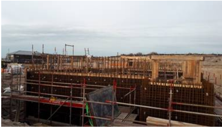
Bouw kelderwanden station Hoek van Holland Strand
