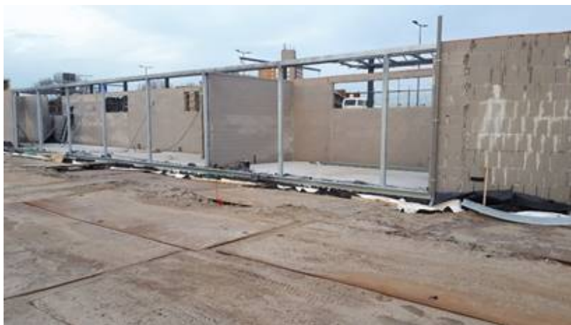
Bouw commerciële ruimten in de plint van station Hoek van Holland Haven
