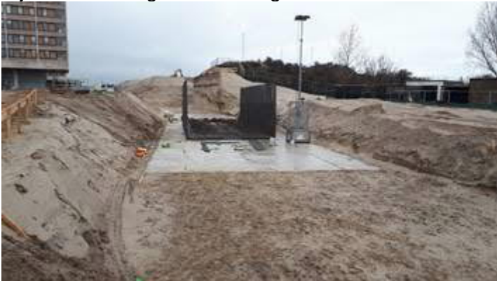
Start bouw tunnelementen
