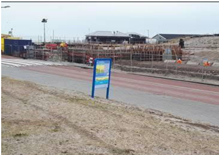
Bouw kelderwanden station Hoek van Holland Strand
