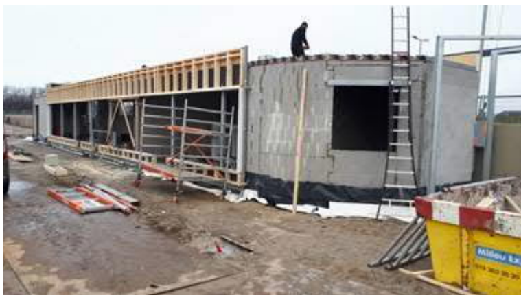
Bouw van de voorzieningen in de plint van station Hoek van Holland Haven
