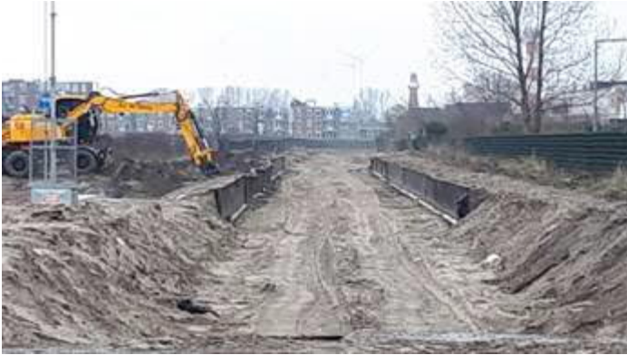
Ontmanteling voormalige station Hoek van Holland Strand
