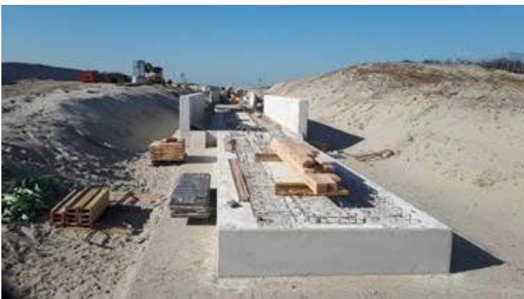
Bouw open bak westzijde Strandboulevard
