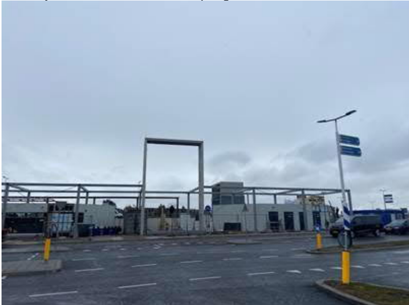
Bouw algemene ruimten Station HvH Haven
