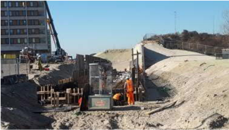
Bouw tunnelementen Strandweg
