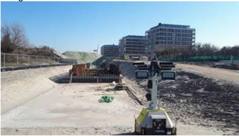
Bouw open bak bij de Paviljoensweg
