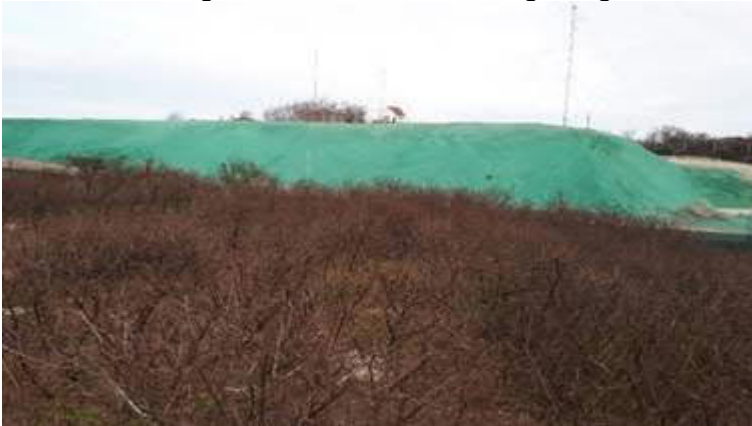
Aangebrachte anti-stuifmiddel over voorbelasting Strandweg
