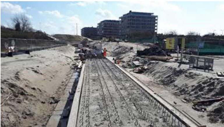
Bouw moten spoorwegovergang Strandboulevard
