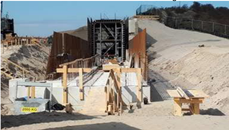
Bouw tunnelementen Strandweg
