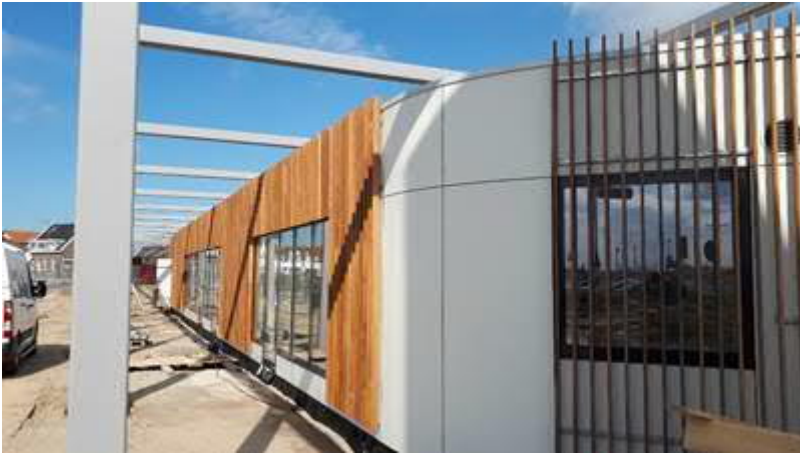
Bouw algemene ruimten Station HvH Haven
