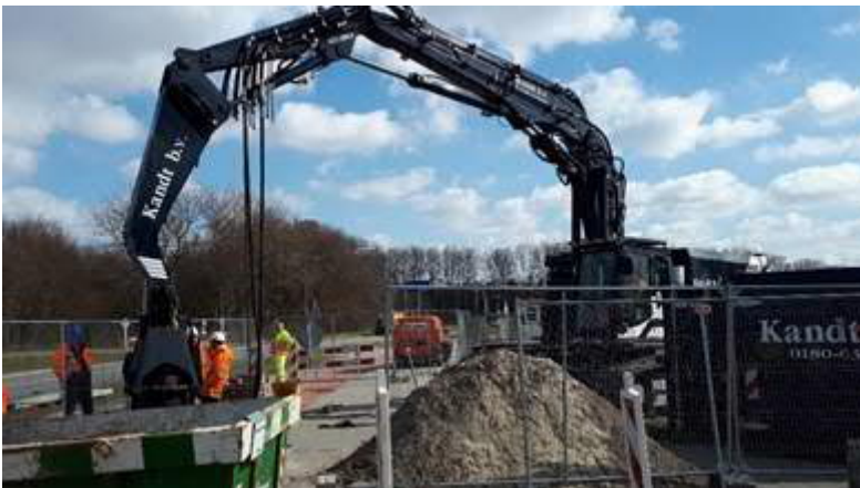
Boren funderingspaal bovenleiding nabij Strandweg
