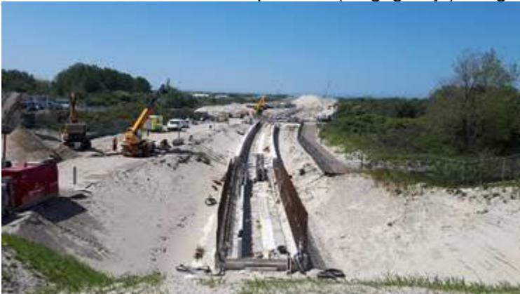
Foto tunneluitgang en open bak nabij de Paviljoensweg
