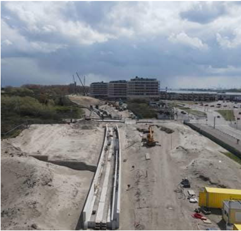
Open bak westzijde Strandboulevard/ Foto uit droneopname A. Tempelaars
