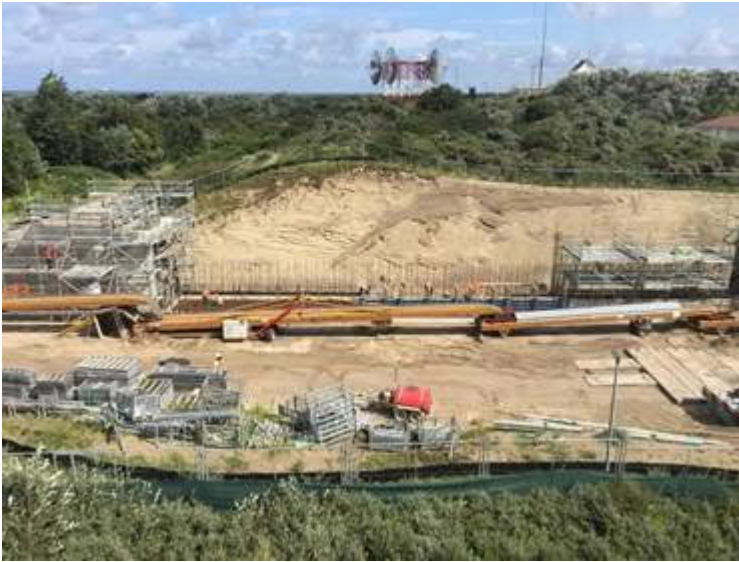
Bouw laatste stuk tunnel (Foto C. Pieterse)
