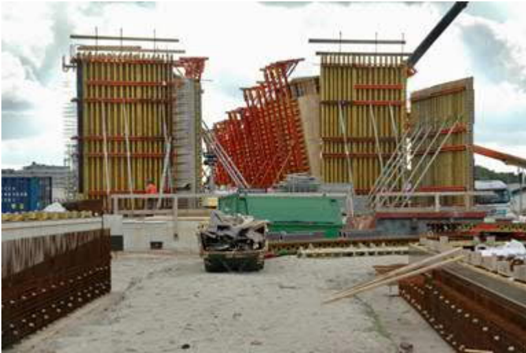
Bouw station Hoek van Holland Strand – bekistingen zijwanden
