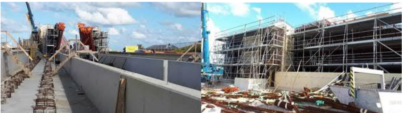
Bouw station Hoek van Holland Strand – perrons
