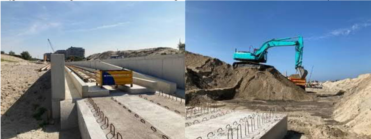
Open bak westzijde Strandboulevard met gemonteerde rails Ontgraven grond voor realisatie spoorbaan
