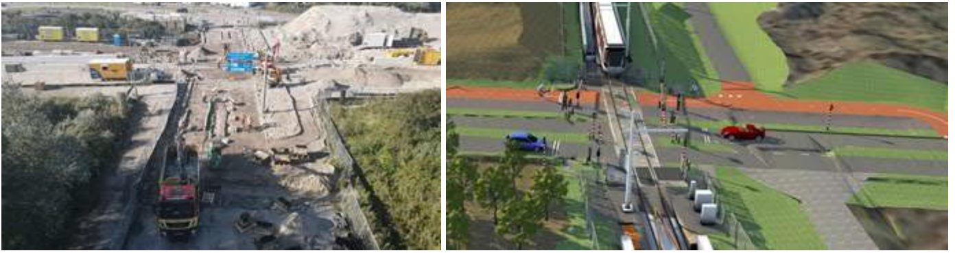
Strandboulevard: Drone-opname voortgang aanleg spoorovergang/ Impressie situatie spoorovergang
