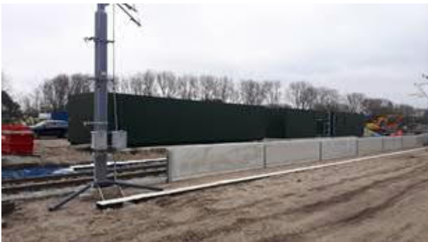
Beveiligingsunit en Gelijkrichterstation
