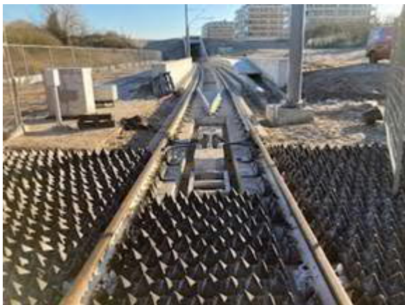
Open Bak en einde tunnel bij Paviljoensweg
