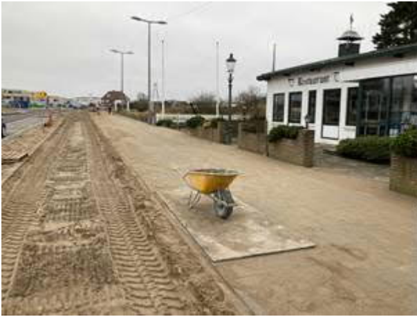
Aanbrengen bestrating langs restaurant Het Jagershuis
