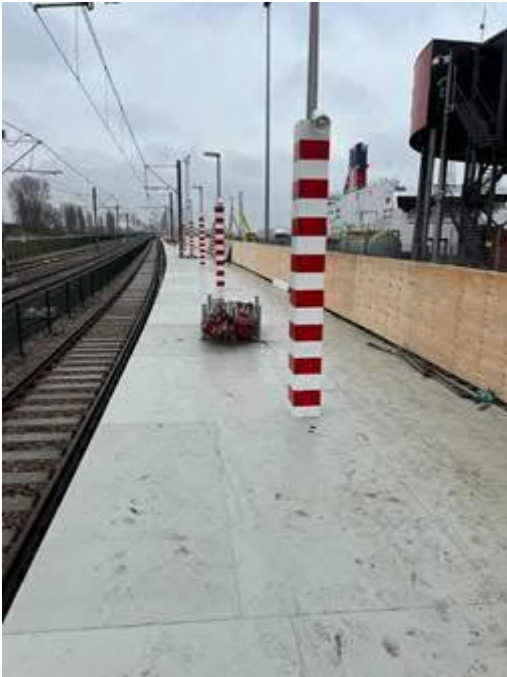
Nieuw tijdelijk perron oostelijk van station Hoek van Holland Haven
