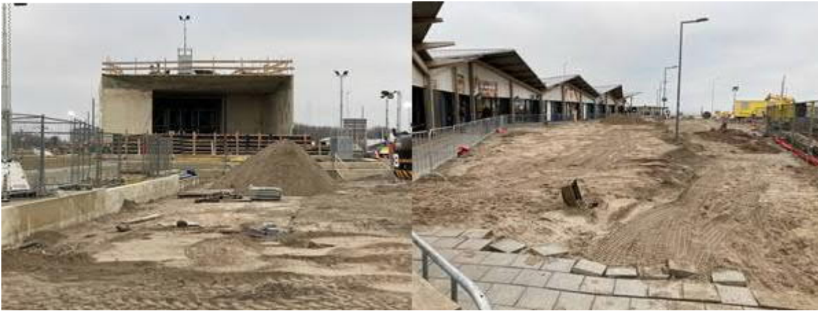
Werkzaamheden Strandplein voorzijde station Strand Werkzaamheden voorzijde winkels Badweg
