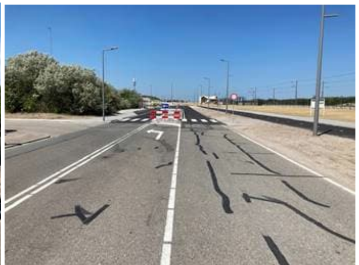
Herstel toplaag asfalt rijweg Badweg
