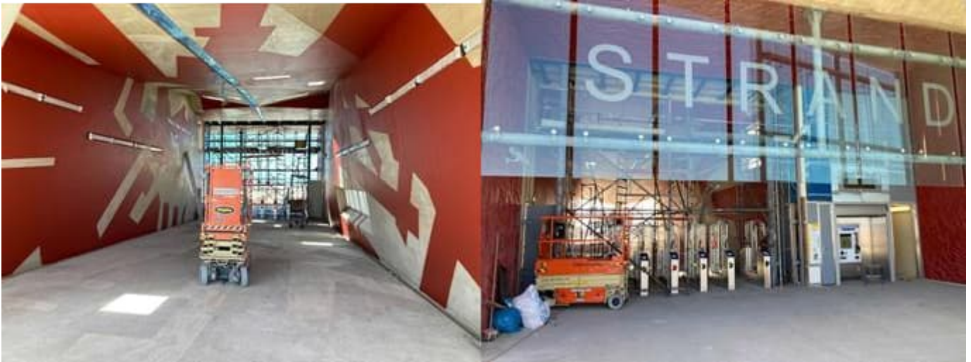
Havenmotief binnenzijde station Hoek van Holland Strand
