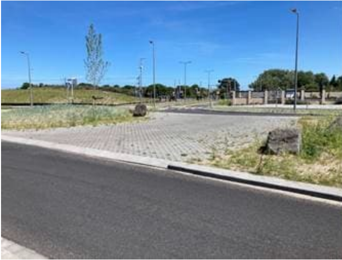
Bypass in Ovonde Badweg
