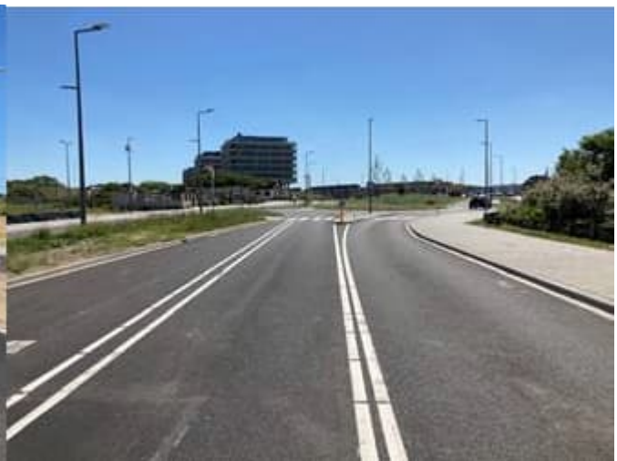
Asfaltering rijweg Badweg
