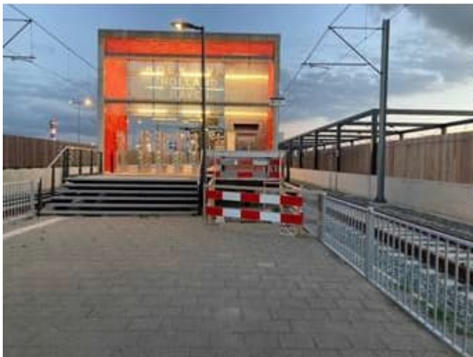
Station Hoek van Holland Haven met aan de rechterzijde de locatie voor de lift
