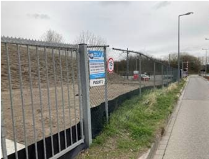
Verwijderen bouwhekken langs Strandweg
