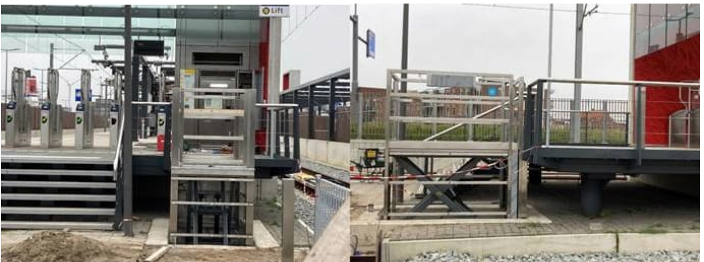
Station Hoek van Holland Haven, het geplaatste liftplateau
