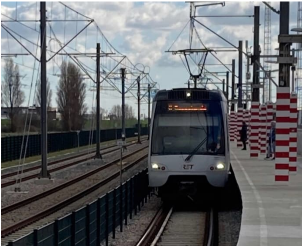
Tijdelijk station Hoek van Holland Haven
