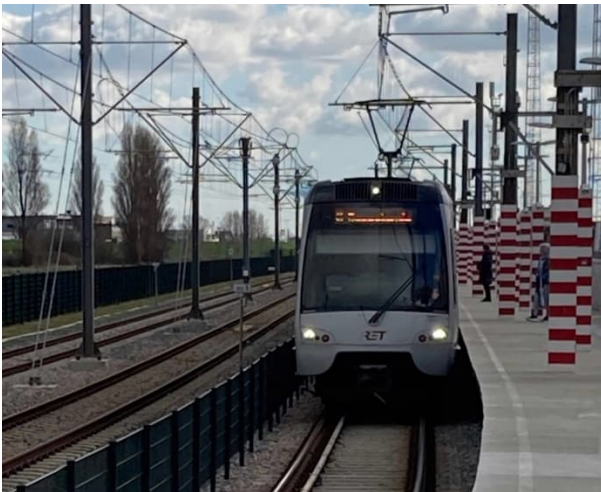
Verwijderen tijdelijk station Hoek van Holland Haven
