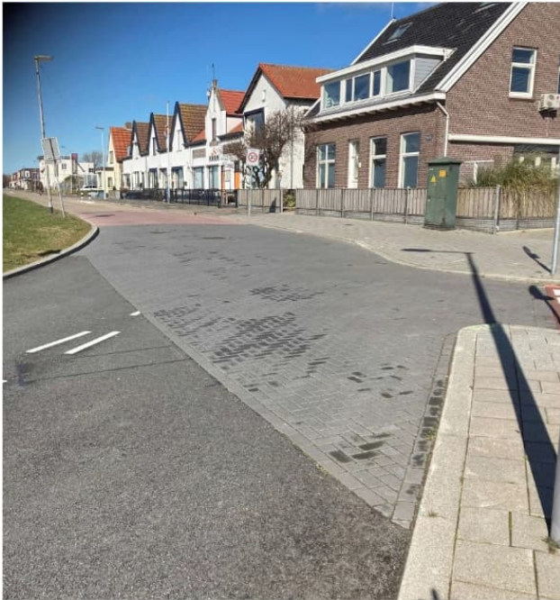
Stationsweg- herstel verharding rijbaan
