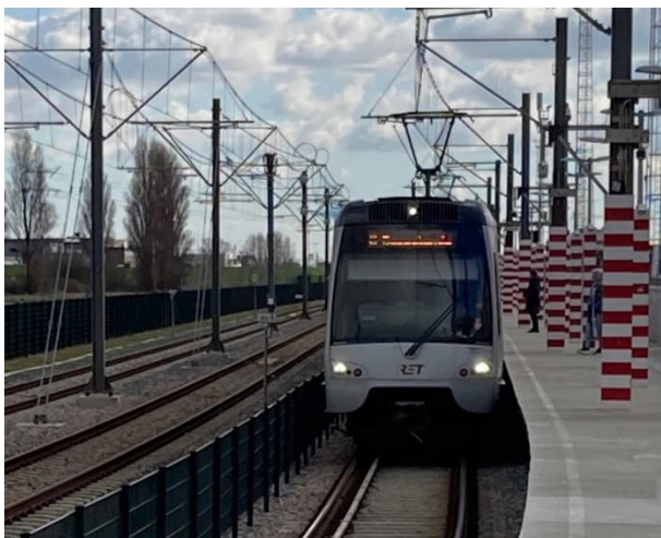
Verwijderen tijdelijk station Hoek van Holland Haven
