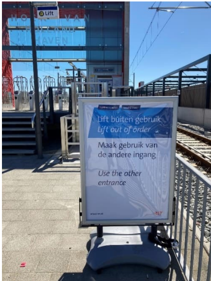
Plateaulift bij station Hoek van Holland Haven nog niet in gebruik
