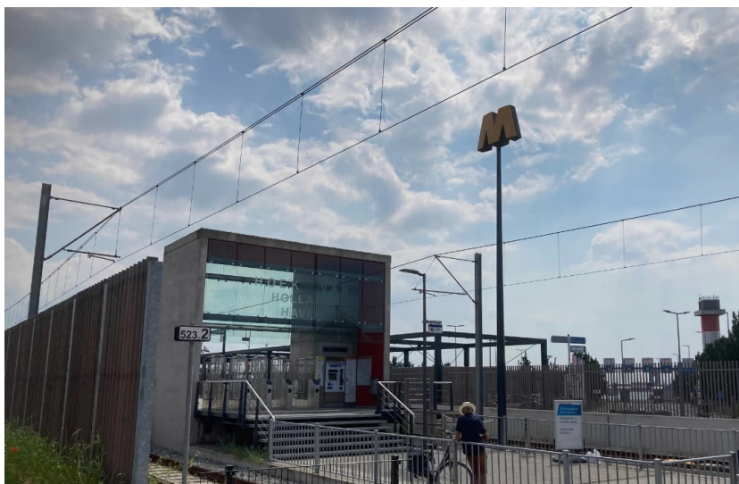
M-mast bij station Hoek van Holland Haven
